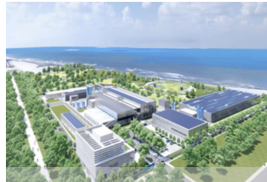
新竹海水淡化廠土木鋼構工程
